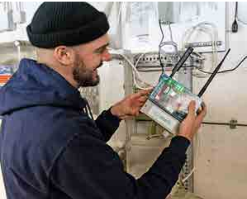
Ein Metr-Mitarbeiter bei der Installation des M-Gates
