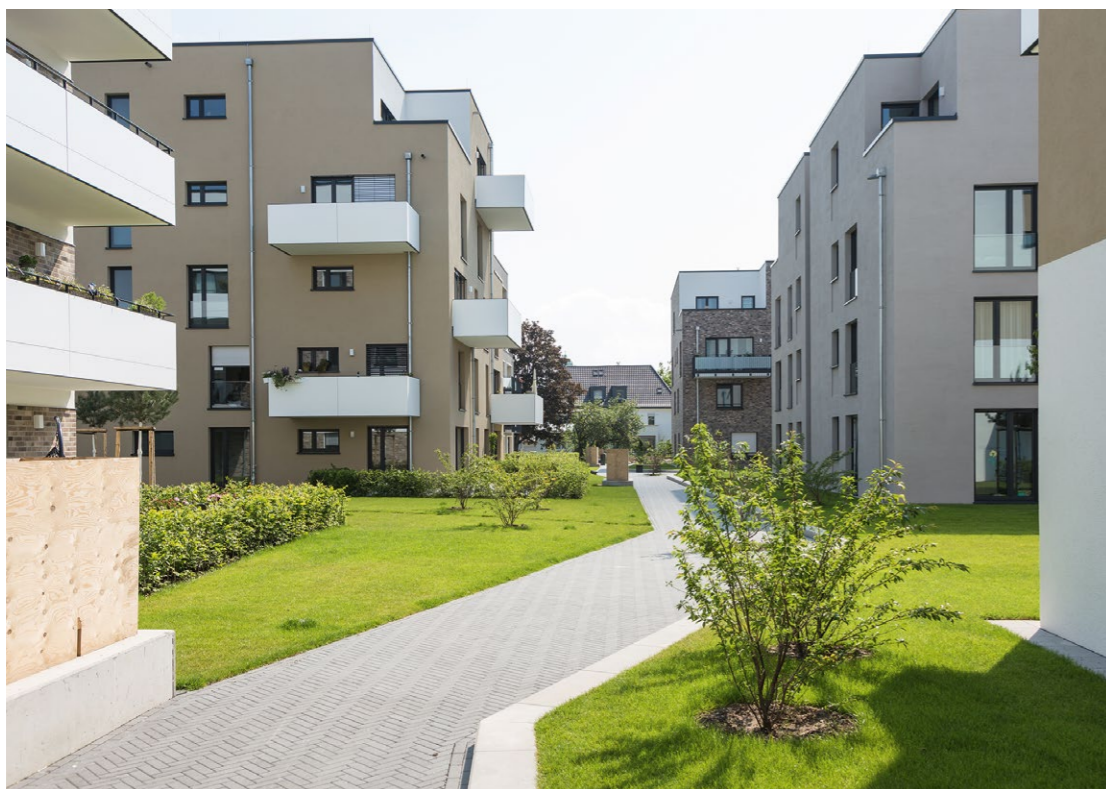
Erhöhtes Sicherheitsniveau und die Möglichkeit der zeitnahen Intervention: Die Integration von Rauchwarnmeldern in die digitale Infrastruktur schafft einen echten Mehrwert.
