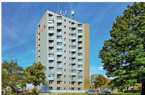
Das Wohnhaus Am Aubuckel hat die GBG im Jahr 2022 saniert und technisch auf den neuesten Stand gebracht. Es bietet 60 geförderte Wohnungen
